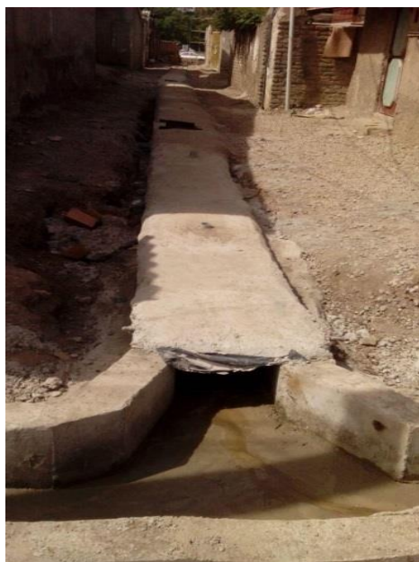
اجرای جدول سرپوشیده بطول ۴۵ متر فرعی اول خیابان فردوس ۳
