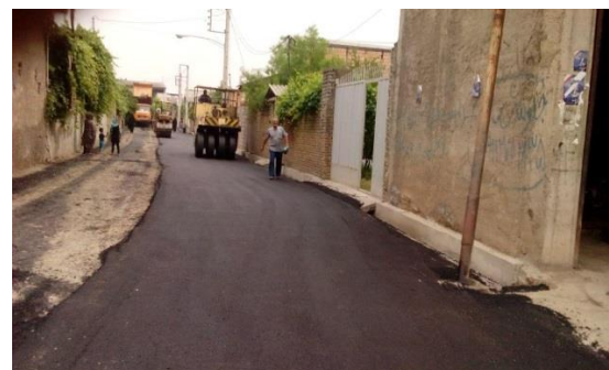
اجرای عملیات آسفالت خیابان فردوس ۱۱
