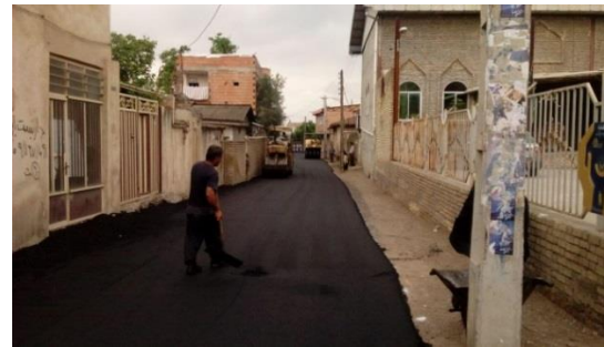
اجرای عملیات آسفالت خیابان فردوس ۲۱
