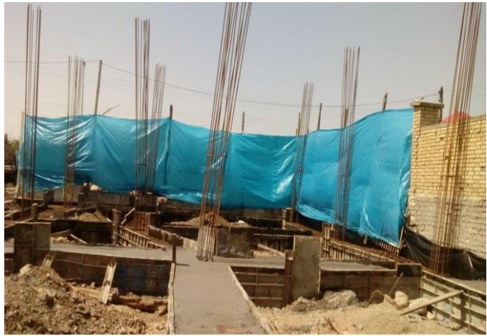
اجرای بتن ریزی فنداسیون ساختمان شهرداری بمساحت ۴۰۰مترمربع
