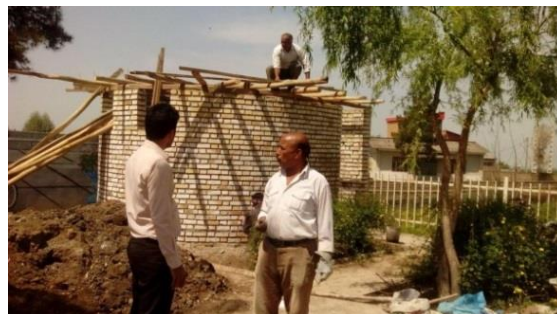
احداث چهار چشمه سرویس بهداشتی در پارک سلامت
