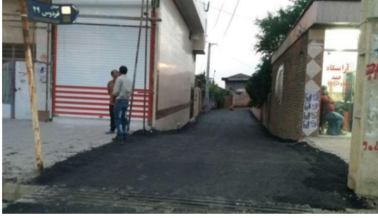
اجرای عملیات آسفالت خیابان فردوس ۲۹
