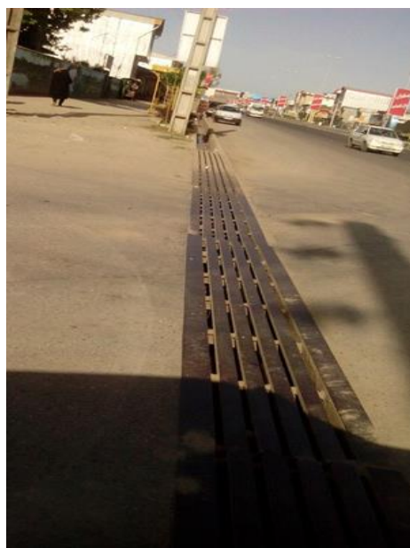
احداث پل فلزی تقاطع خیابان های فردوس ۱۳ و ۹
