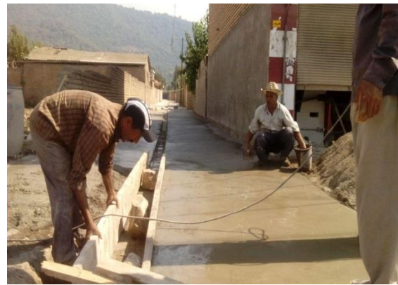
بتنی نمودن خیابان فردوس ۱۰ و اجرای کانیوو بصورت همزمان
