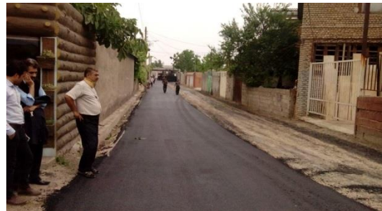
اجرای عملیات آسفالت خیابان فردوس ۳
