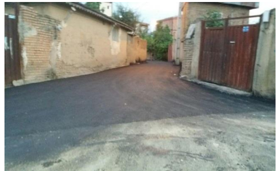
اجرای عملیات ادامه آسفالت خیابان فردوس ۳۲
