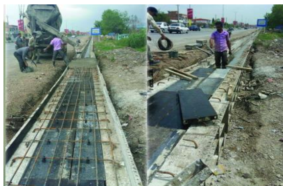
اجرای دال مسلح در ضلع جنوبی محور خیابان امام رضا (ع)، تقاطع جاده نفت
