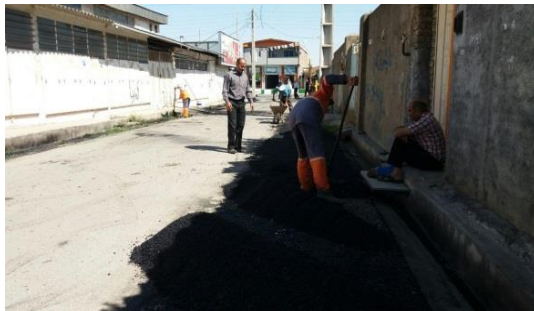
اجرای عملیات لکه گیری آسفالت خیابان فردوس ۲۲
