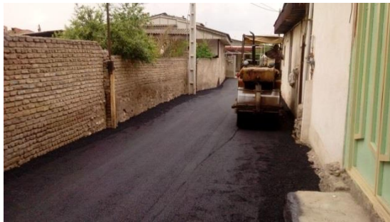
اجرای عملیات آسفالت خیابان فردوس ۱۹
