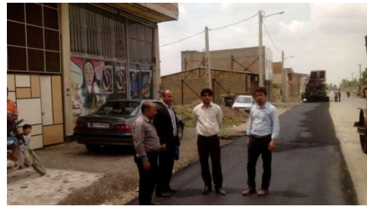
اجرای عملیات آسفالت فردوس ۱۳
