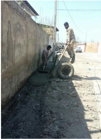
اجرای عملیات عمرانی احداث کانپو در فردوس ۳
