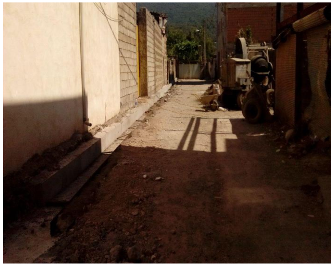
اجرای عملیات عمرانی احداث کانپو و خیابان فردوس ۴۸
