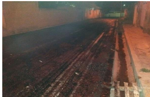
اجرای آسفالت فردوس ۲۹ و کوچه های شهید صفر خانی و شهیدشاهی
