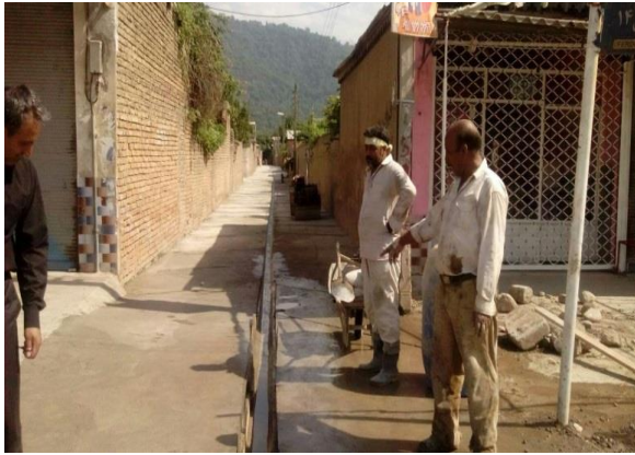
عملیات زیرسازی و اجرای کانیوو و بتن ریزی خیابان فردوس ۱۴
