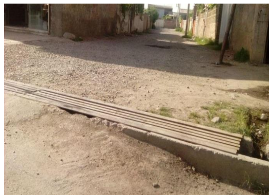
اجرای پل فلزی مقابل ساختمان شورا
