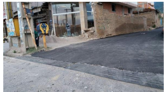
اجرای عملیات آسفالت خیابان فردوس ۳۲
