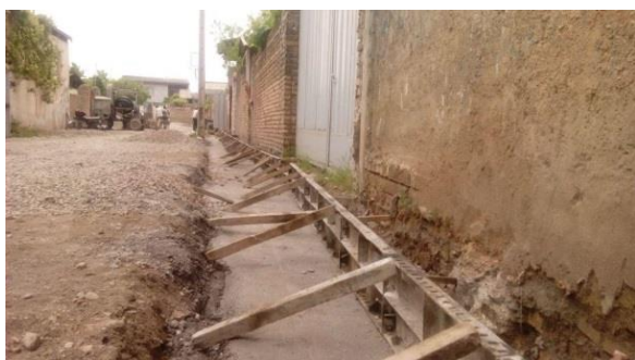
اجرای عملیات جدول بندی فردوس ۱۱
