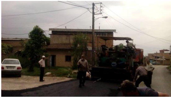
اجرای عملیات آسفالت خیابان پشت مسجد جامع قرق
