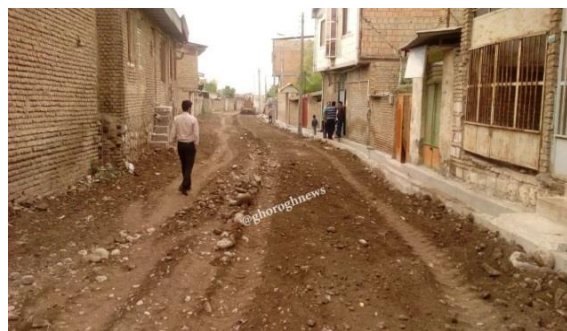
عملیات زیرسازی فردوس ۲۹
