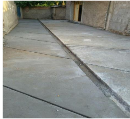
اجرای عملیات بتن ریزی فردوس ۱۴
