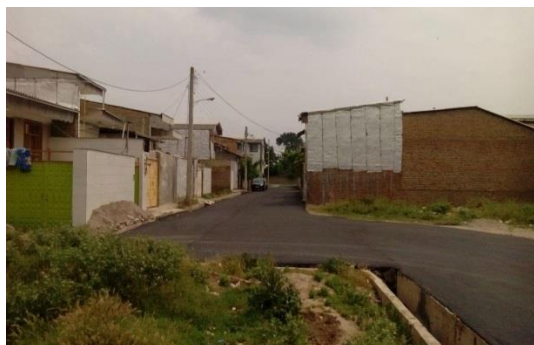
اجرای عملیات آسفالت فرهنگ ۷
