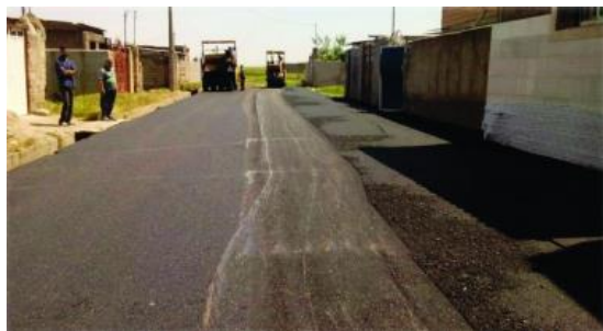
اجرای عملیات آسفالت فرهنگ ۲
