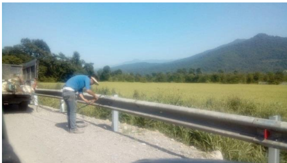
اجرای گارد حفاظتی در حاشیه جاده اصلی - ورودی جنوبی شهر قرق
