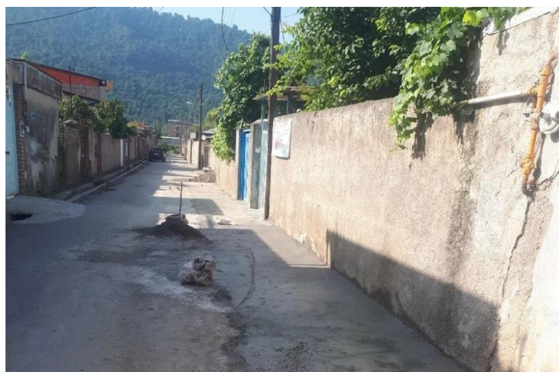
اصلاح و ترمیم بتن بتن خیابان فردوس ۱۸
