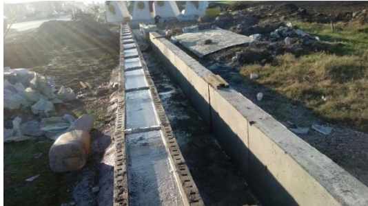
اجرای جدول ۵۰*۵۰ به طول ۱۷۰ متر ورودی شرقی شهر
