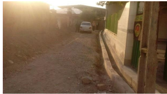
اجرای جدول ۳۰*۳۰ در ۳۰ فرعی فردوس ۳۳، کوچه مسینیه
