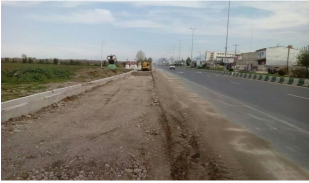
اجرای تسطیح و زیرسازی ورودی شرقی شهر
