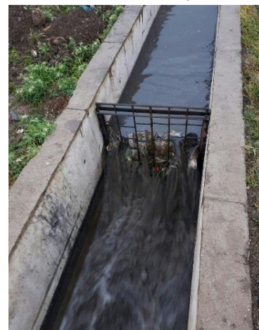
نصب آشغالگیر در نقاط مختلف از مسیر جداول
