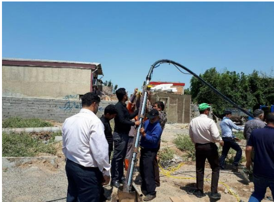
نصب تاسیسات مکانیکی و برقی چاه آب پارک شهدا
