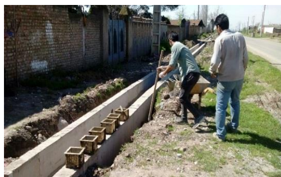
نمونه گیری مستمر از بتن جداول جهت انجام آزمایشات بتن
