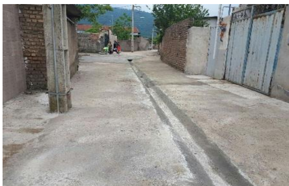
بتن ریزی همراه با کانپو و وسط خیابان فردوس ۷
