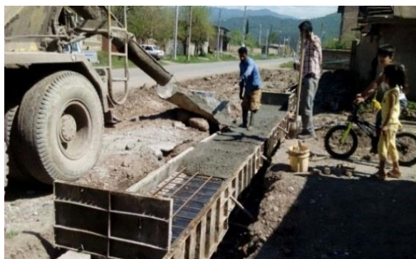
اجرای پل بتن مسلح ورودی معبر فرهنگ ۱۹
