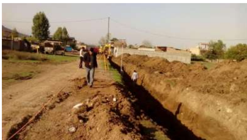
- گود برداری جاده نفت جهت اجرای کانال بمنظور جلوگیری از ورود سیلاب به خیابان های ضلع جنوبی شهر و هدایت آب های سطحی
