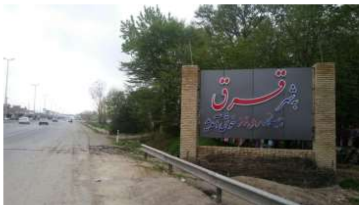
نصب تابلوی ورودی شهر
