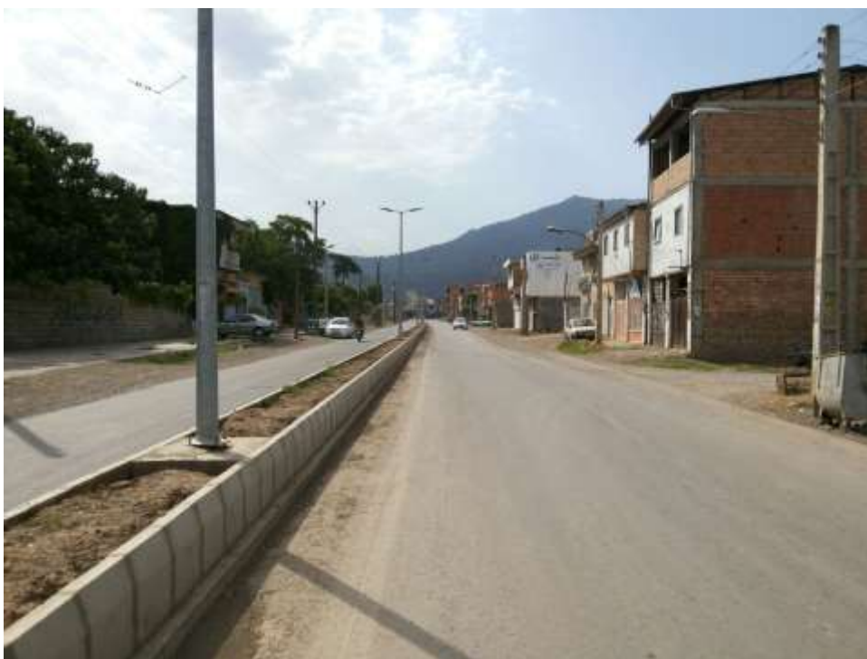
اجرای بلوار خیابان قلی آباد (فردوس ۱۳) همراه با تامین روشنایی آن
