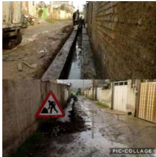
-اجرای جدول بندی خیابان فردوس ۴۶ فرعی شقایق ۶
