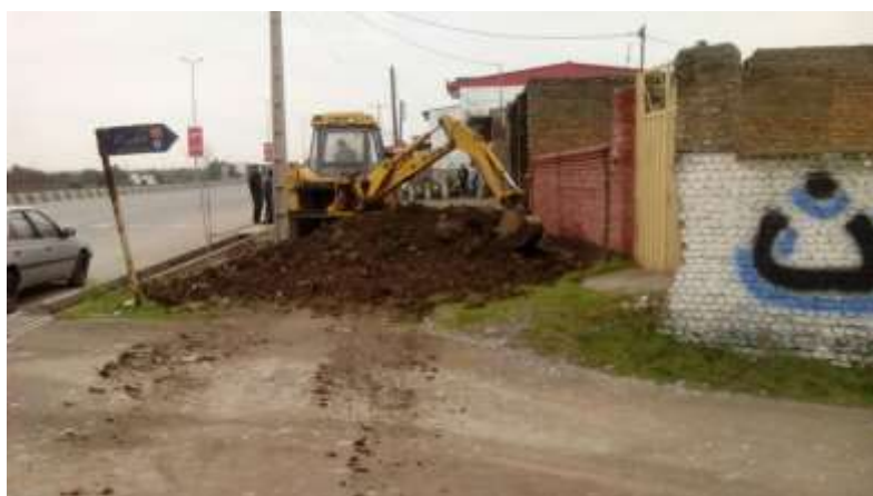
- تسطیح پیاده رو حد جنوبی خیابان اصلی جهت شروع عملیات موزاییک فرش
