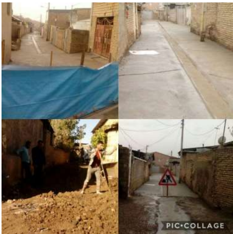
- اجرای بتن ریزی وجدول خیابان فردوس ۳۲ فرعی سوم سمت راست
