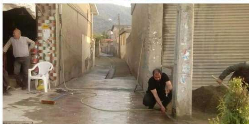
- اجرای زیرسازی و جدول بندی و بتن ریزی خیابان فردوس ۲۴
