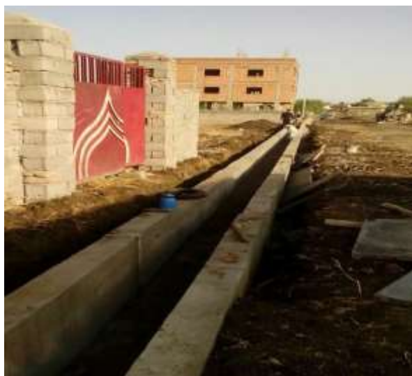
- اجرای جدول ۵۰ × ۵۰ در ابتدای زمین برادران کبیر جهت جلوگیری از نفوذ سیلاب به خیابان های اطراف
