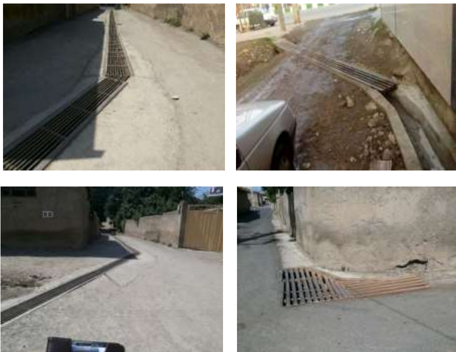
-نصب پل آهنی جهت بهبود عبور و مرور بر روی جداول احداثی (با اعتباری بالغ بر ۱۴۰/۰۰۰/۰۰۰ میلیون ریال)
