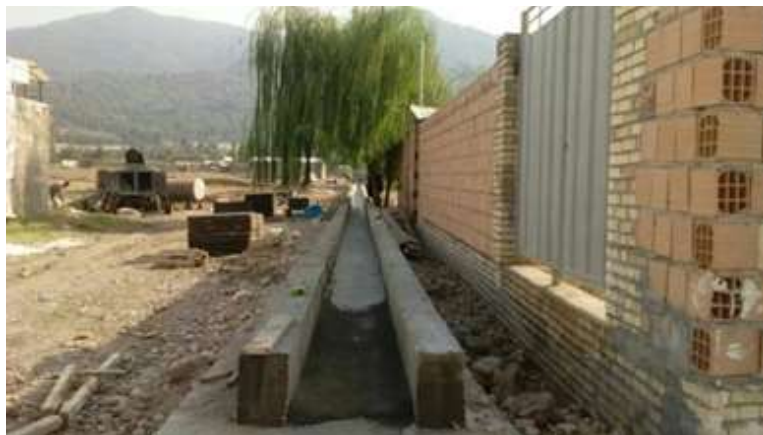
-اجرای ۲۰۰متر جدول ۵۰×۵۰ در فرعی فردوس ۴۴
